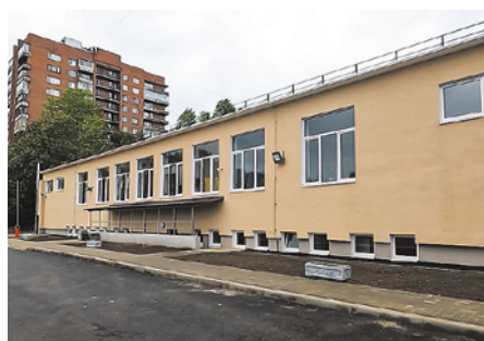
Новая станция скорой помощи на Учительской улице
