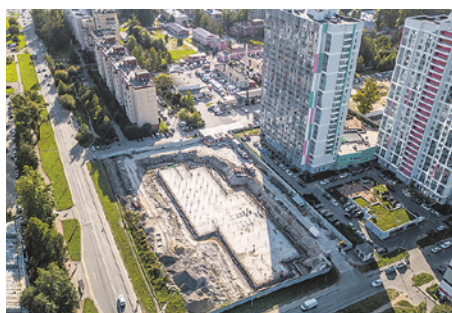
Строительство взрослой поликлиники
