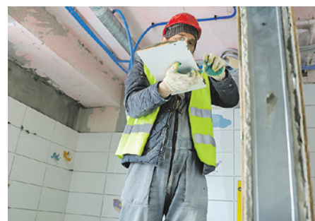
Ход капитального ремонта поликлиники № 118
